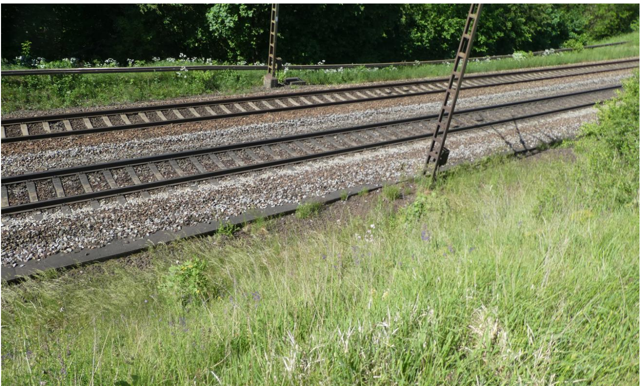
Abbildung 6: Bahndamm und steil abfallendes Untersuchungsgebiet (Foto: T. Buchschuster)
